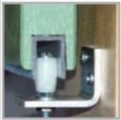
Guidage bas fixé en façade
