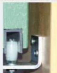
Guidage bas, olive sur équerre (volet bois)
