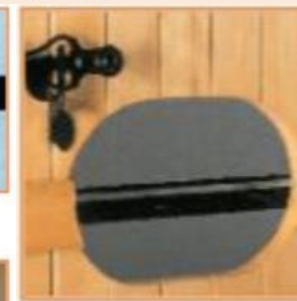
Tringlage des volets à lames
